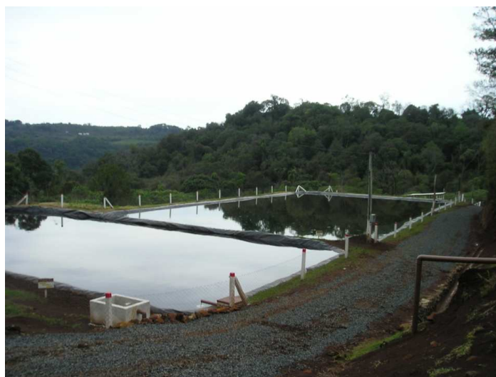
Figura 31 - Vista parcial das unidades de Tratamento Biológico do Chorume, Aterro Sanitário Erval Velho
