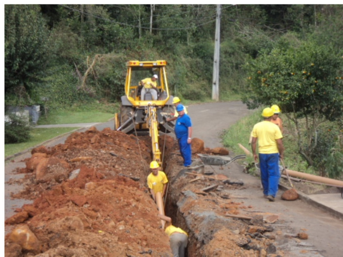
Implantação de rede coletora de esgoto na Rua da Limeira em Luzerna
