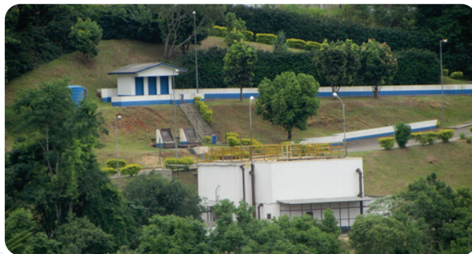
Foto da ETE Luzerna
